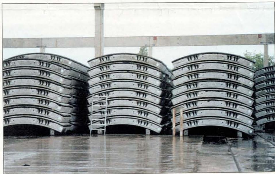
In totaal zullen 13.000 tunnelsegmenten van ongeveer 5 ton worden gebruikt voor de realisatie van de 1200 meter lange tunnelkokers.
